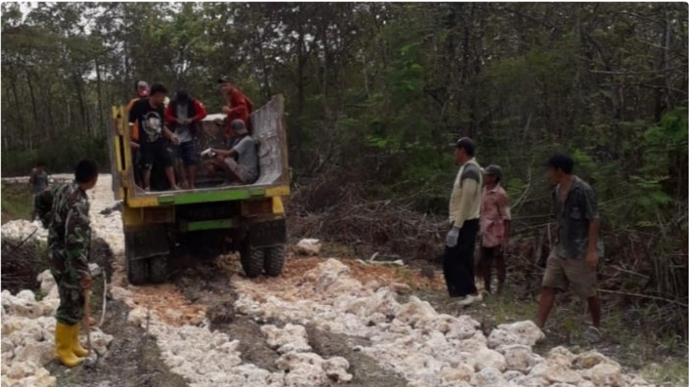
Giat Satgas TMMD Kodim 0721/Blora Keraahkan Dump Truck Untuk Angkut Material. Senin, (09/05/2022).
